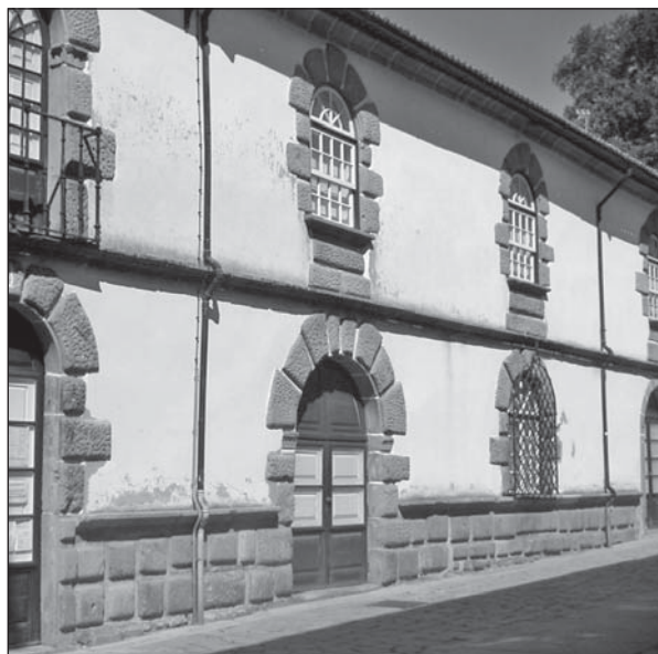
Braga, Casa da Roda , séc. XIX, arquitectura civil
