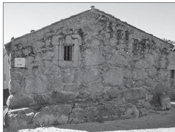
Caria, Casa da Roda, 1784, arquitectura civil
